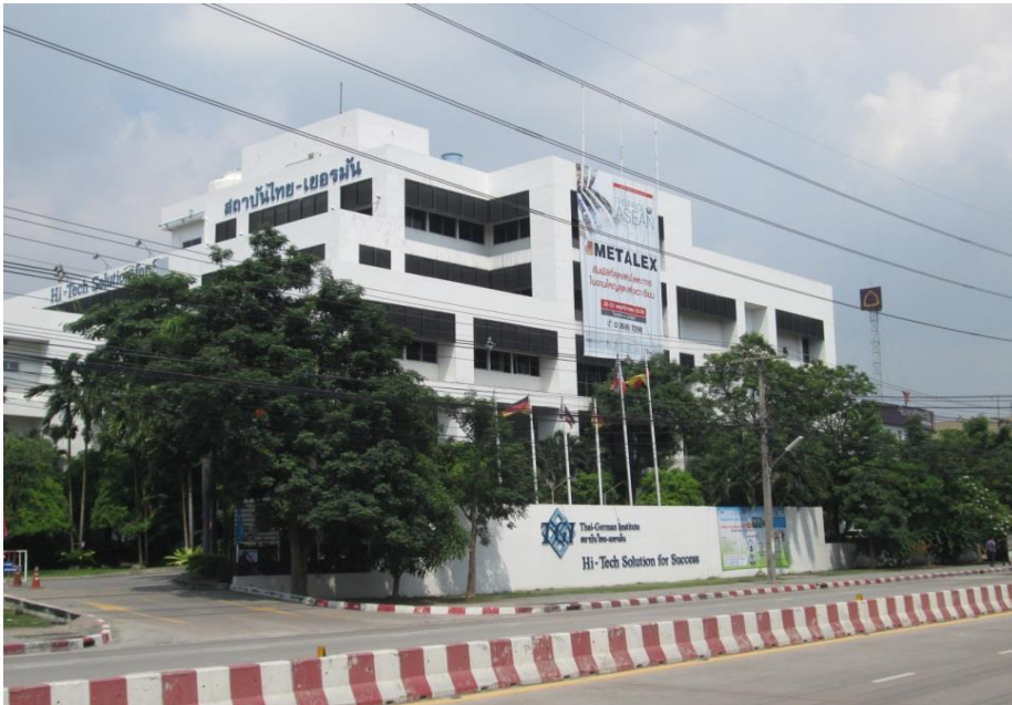
TGI外観(正面より)
